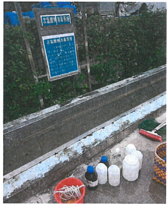
污水厂排水口（DW001）
